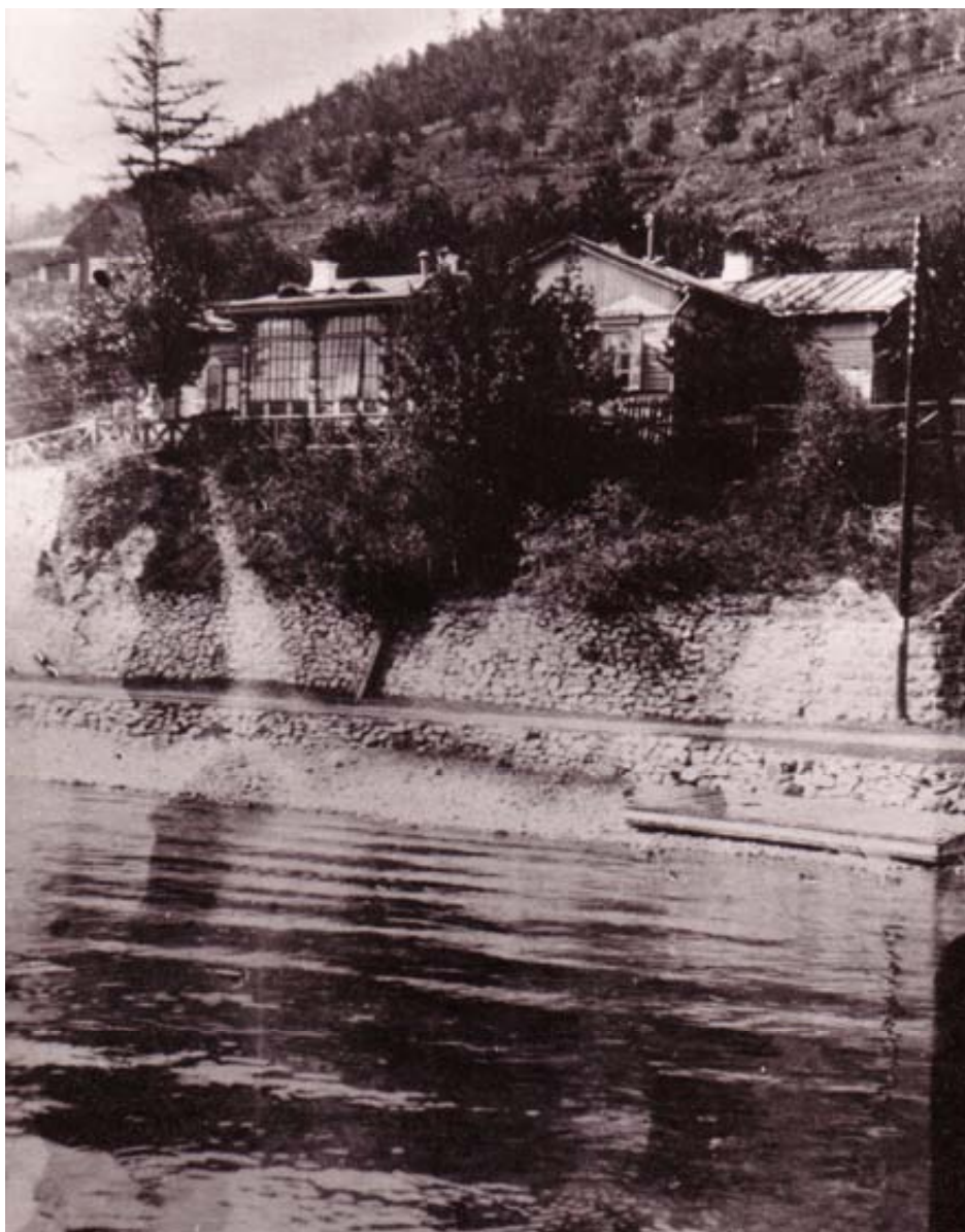
Фото 7. Здание БЛС в пос. Маритуй.
